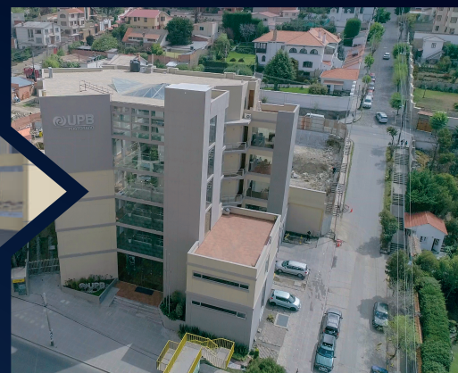
Edificio de Postgrado de la Universidad Privada Boliviana Av. Hernando Siles No 5080 esq. Calle 5 Obrajes - La Paz
