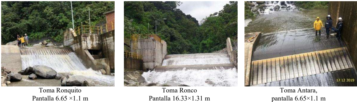
Figura 3: Pantallas con efecto Coanda emplazadas en los vertederos de las obras de toma de estudio. Fuente: Elaboración propia.
