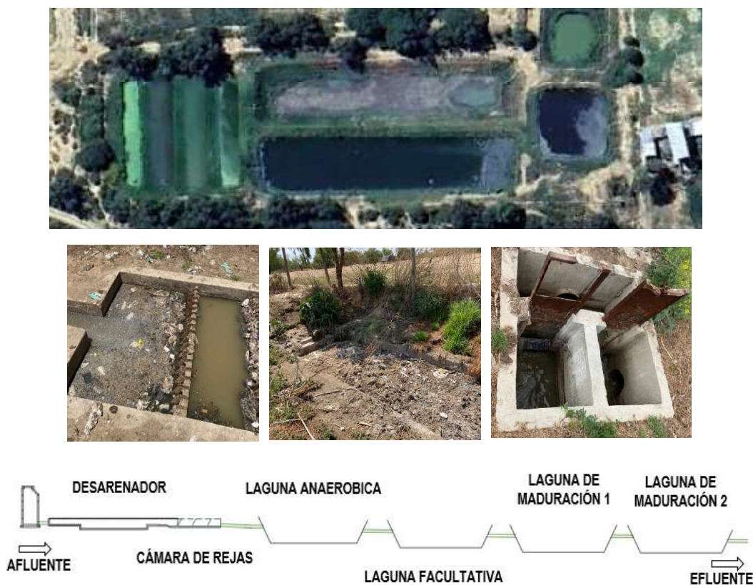
Figura 6: Planta de tratamiento de aguas residuales de Tarata.
