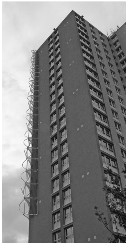
Figura 5: Aerogenerador de tipo Crossflex [8].
