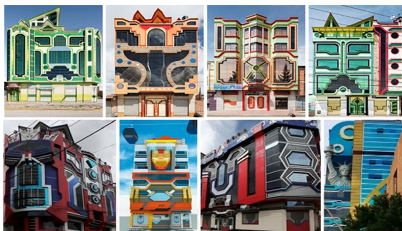
Figura 14: Arquitectura Neo-andina de Fredy Mamani y arquitectura “Transformer” de Santos Churata. Fuente: Sitios de internet.
