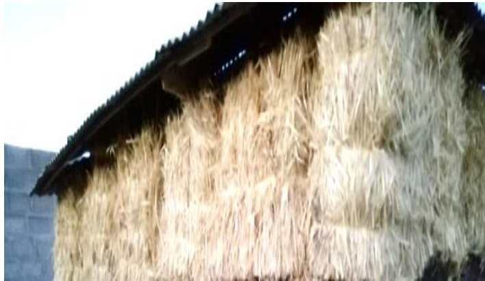
Figura 8: Montaje de la armadura y colocación de la calamina sobre la vivienda.
