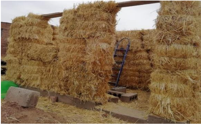
Figura 7: Dimensión de la paca de avena y colocación en reemplazo de muros.
