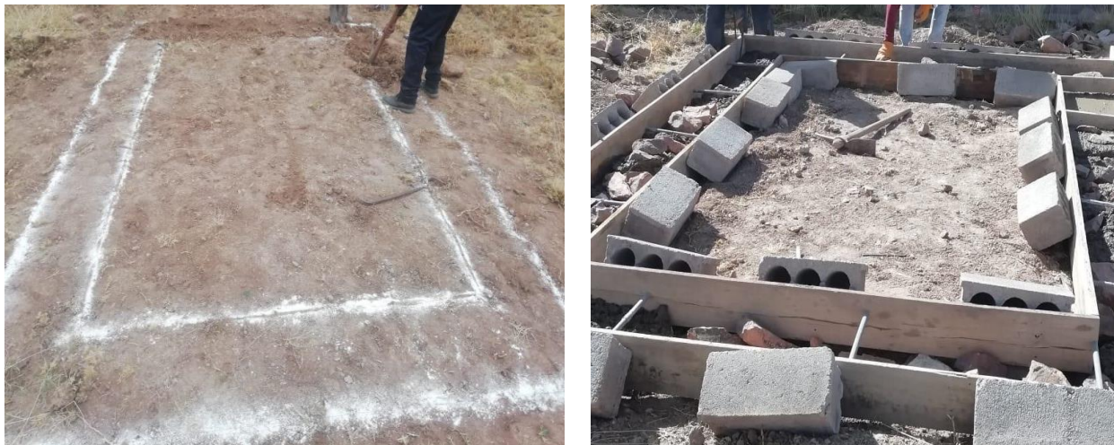
Figura 6: Trazo, replanteo, excavación y encofrados del sobre cimiento.
