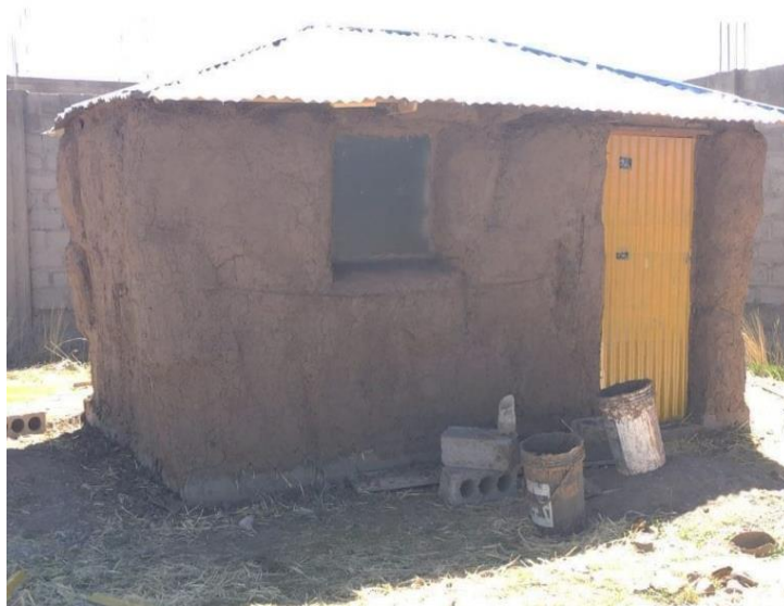
Figura 10: Vivienda construida con pacas de avena concluida.
