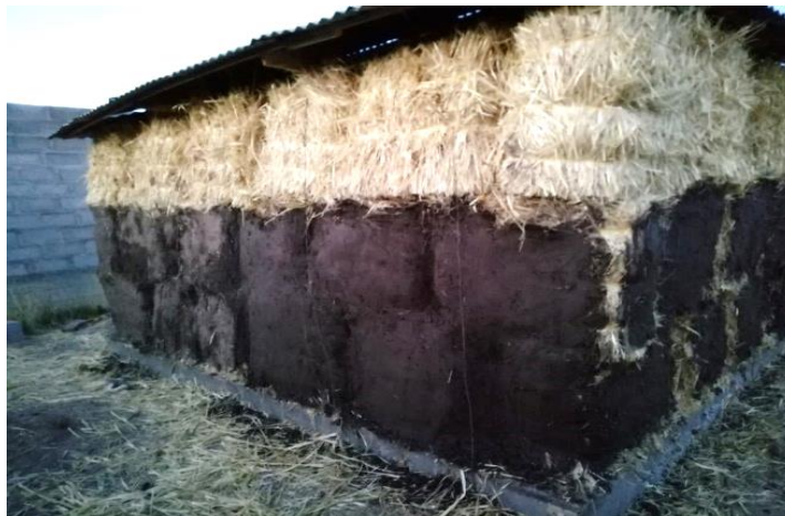
Figura 9: Recubrimiento del muro con barro sobre las pacas de avena con barro.
